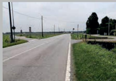
Via Canaletta- tratto di strada che verrà messo in sicurezza con il guard rail
