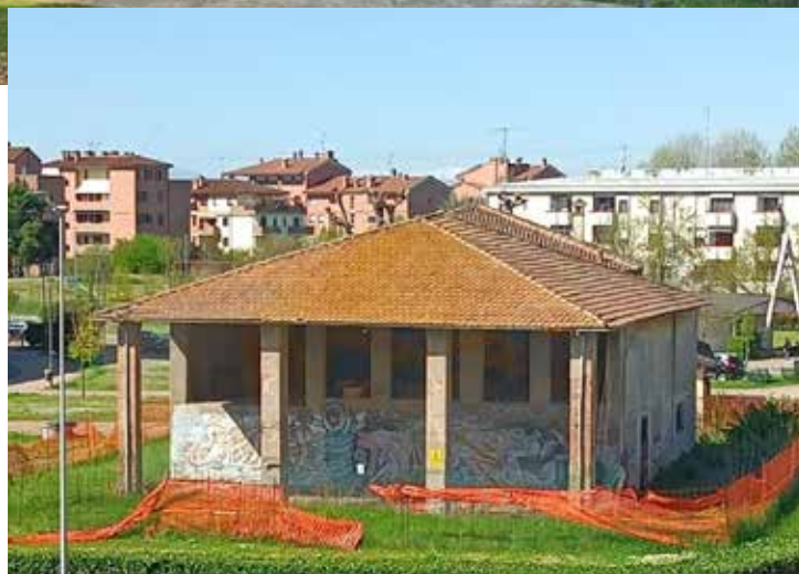
L'ex fienile di Funo: com'era e come è oggi, a lavori in corso
