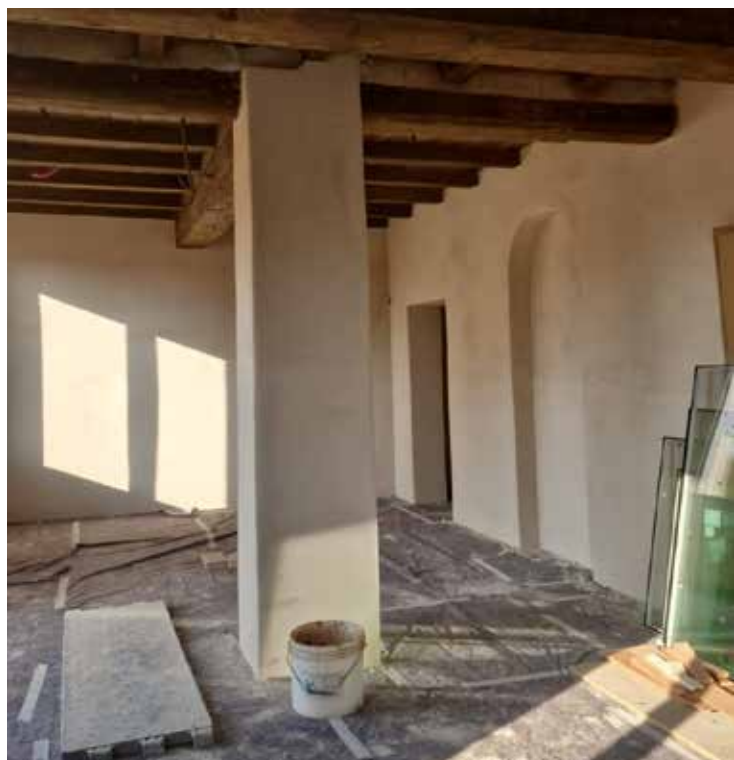
I lavori in corso e il render di come sarà la sala dedicata ai più piccoli della nuova biblioteca a Villa Beatrice
