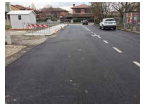
Immagine (4) Nuovo asfalto via Bernardi, costruzione nuovo marciapiedi
